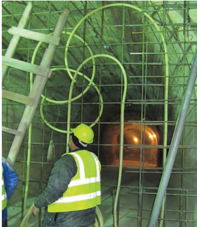
Boucle optique avant coulage du béton.
