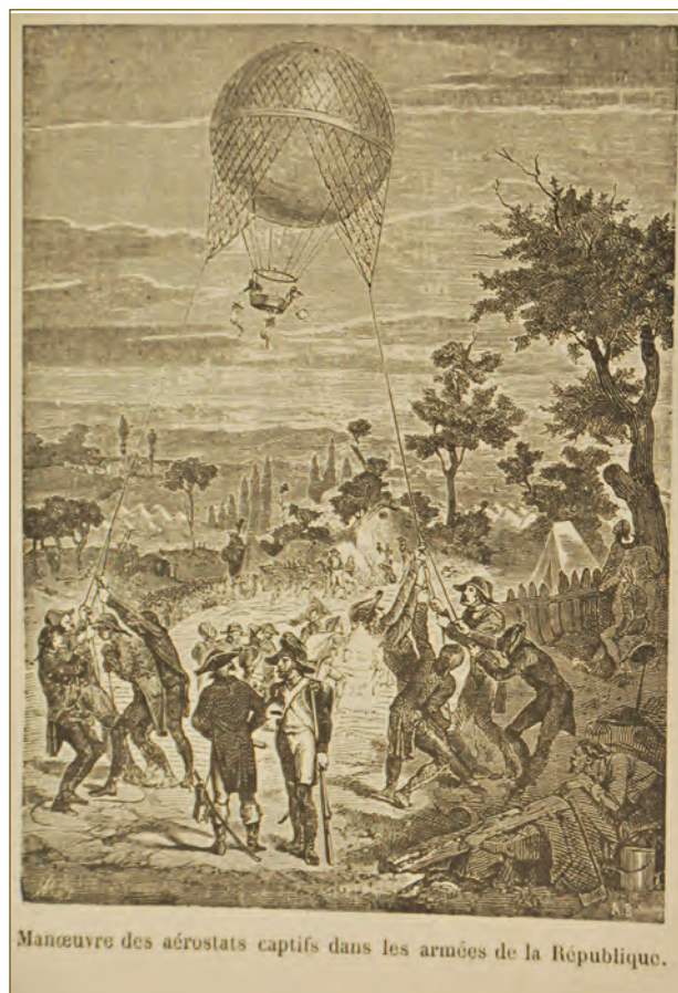
Manceuvre des aérostats captifs dans les armées de la République.
